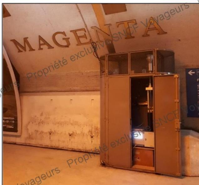
Figure 1 – Baie de mesure en gare de Magenta et visualisation de l'analyseur automatique de particules (TEOM)
