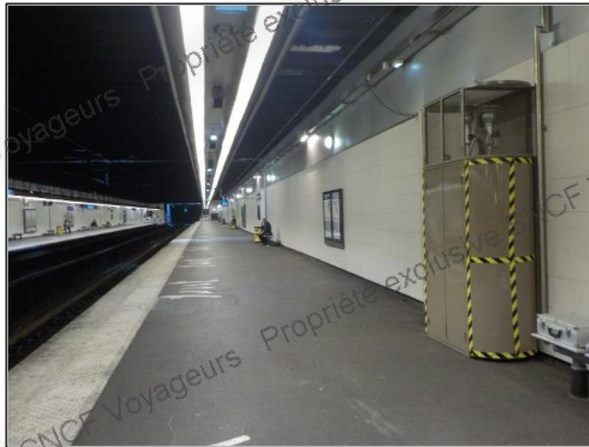
Photographie 1 – Emplacement de la baie de mesure sur le quai N°2
